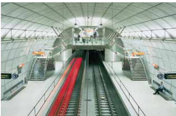
Estaciones de metro, Bilbao, España
